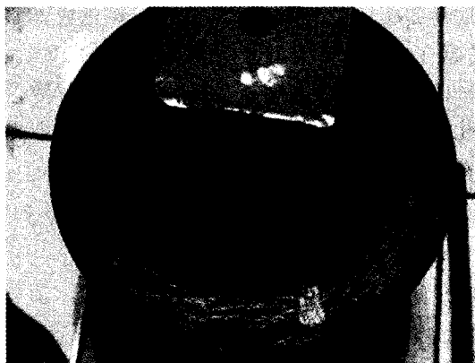
图 2 原结构节点橡胶裂纹情况
